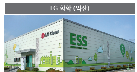
PCS : 3MW / 배터리 : 23MWh 부하 이동용
