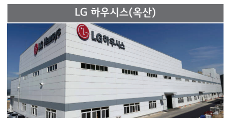
PCS : 500kW / 배터리 : 1.5MWh 부하 이동용
